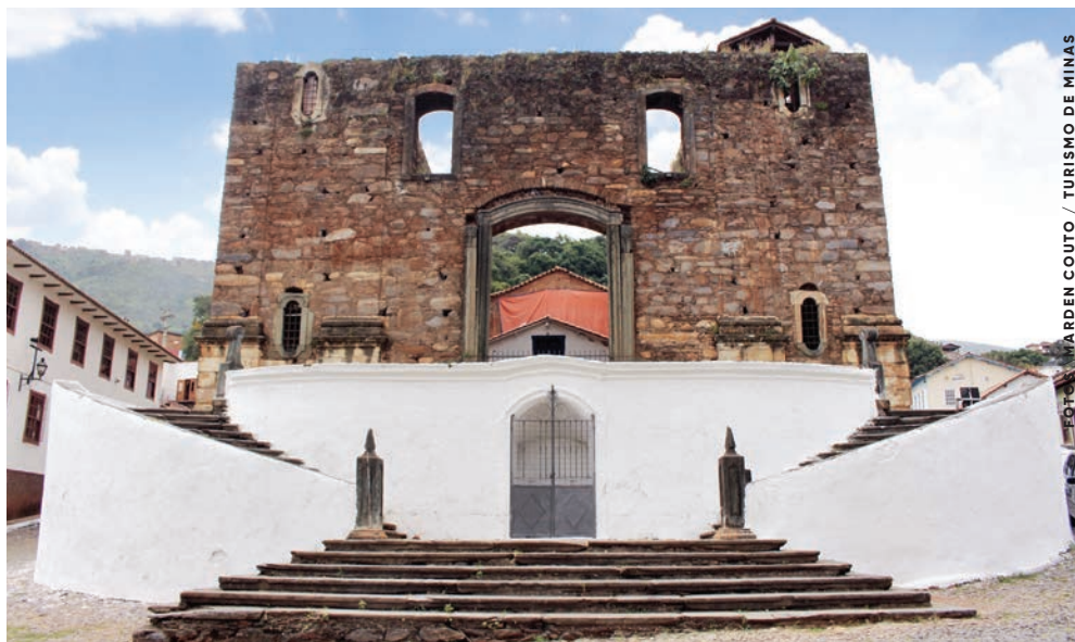
Ruínas da igreja Nossa Senhora do Rosário, em Sabará
