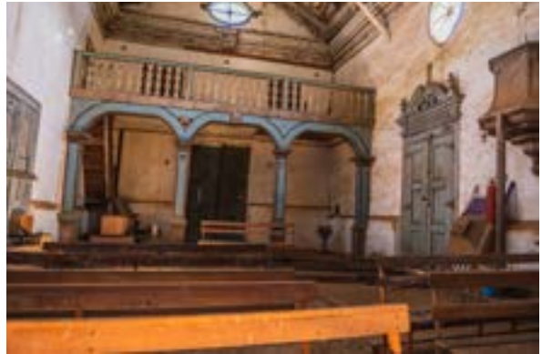
A igreja passará por restauração e obras civis e ganhará proteção contra roubo, incêndios e decargas atmosféricas
