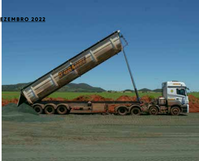
— Escória de ferroníquel é aproveitada na pavimentação de rodovias em Goiás
