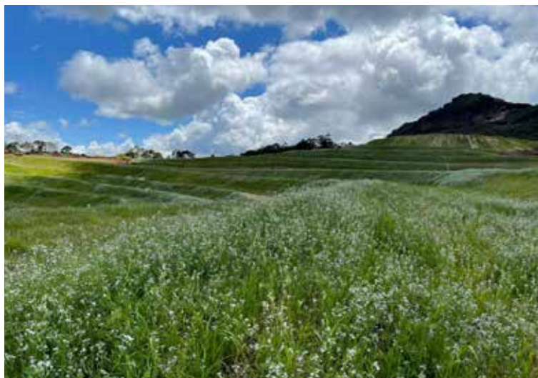
— Área da pilha 1 após remoção total dos finos de rejeito e com o processo avançado de hidrossemeadura
