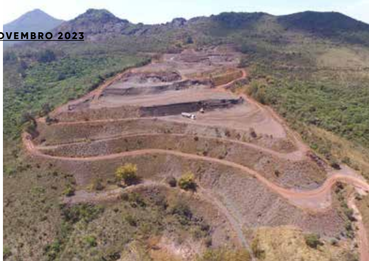
— O antes da pilha de finos de rejeito 1, com o processo de remoção dos finos já iniciado
