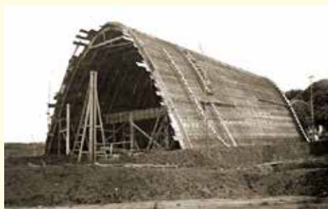
Construção da Igreja São Francisco de Assis, a famosa Igrejinha da Pampulha, que foi inaugurada em 1943
