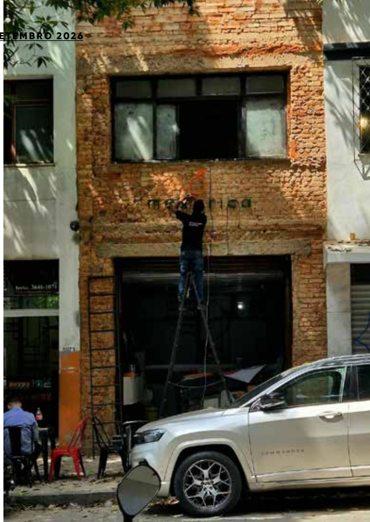
Sorveteria está em implantação na região
